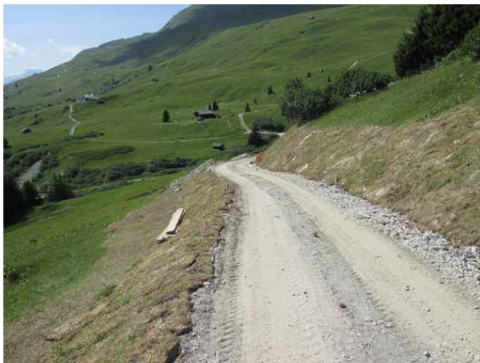
Le talus végétalisé juste après les travaux d'aménagement.
